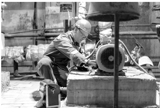
Слесарь-ремонтник Алексей Голубев меняет втулки полумуфты на насосе в цехе ректификации таллового масла и очистки скипидара
